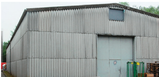
Plaques ondulées amiantées
