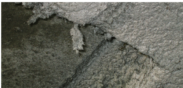
Amiante floqué sur une poutre métallique
