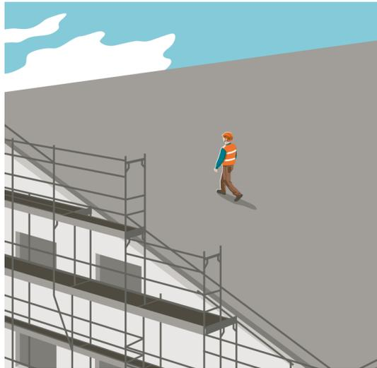
**Règle 2:** Nous sécurisons les zones de chute en bord de toiture à partir de 2 m de hauteur.
