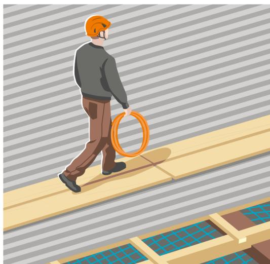
**Règle 5:** Nous ne travaillons que sur des surfaces de toiture résistantes à la rupture.
