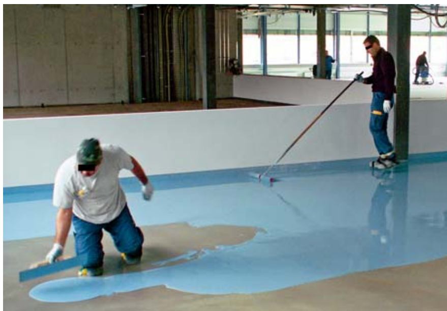
Fig. 2 Travail avec une résine époxy dans le bâtiment
