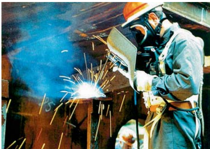
Fig. 4 en haut: soudeur équipé d'un appareil filtrant à ventilation assistée avec casque de soudage et filtre antigaz et particules combiné; en bas: soudeur portant un appareil respiratoire alimenté par tuyau pour l'utilisation dans les locaux exigus.
