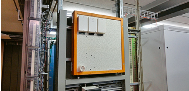
Asbestzement
