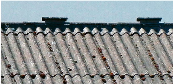
Asbestzementplatten
