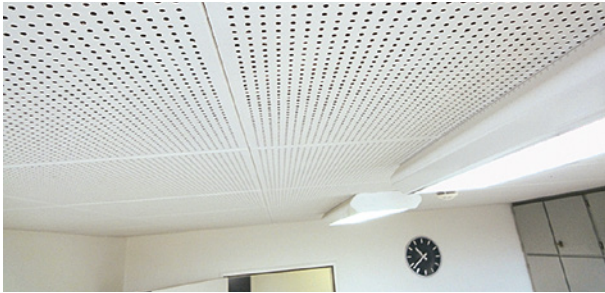
Deckenplatten bei abgehängten Decken
