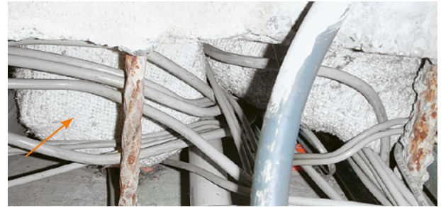
Asbesthaltige Brandschutzkissen
