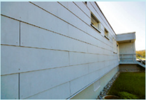
Asbesthaltige Fassadenplatten
