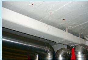
Kabelkanal aus Asbestzement
