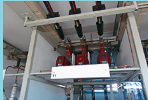
Brandschutzplatten als Trennwand
