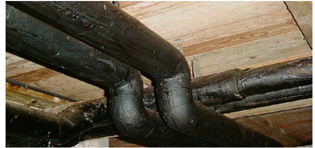
Asbesthaltiger Bitumenanstrich
