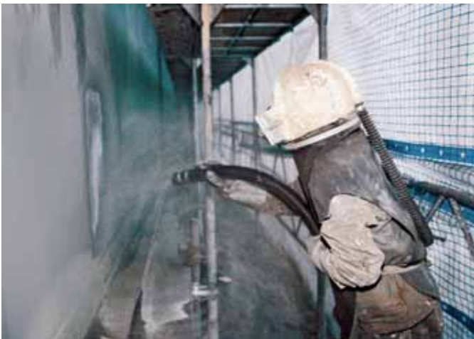
«Sandstrahler»: Arbeitnehmende im Korrosionsschutz werden arbeitsmedi- zinisch untersucht.
