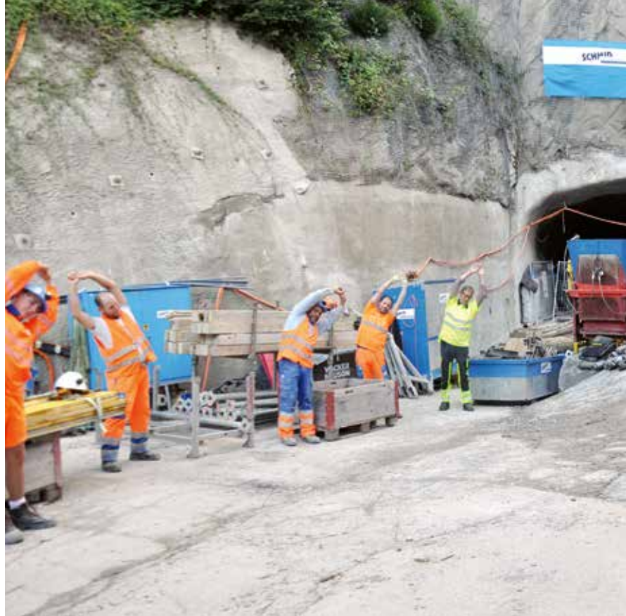
Chez l'entreprise Schmid Bauunternehmung AG, l'échauffement fait partie du temps de travail.
