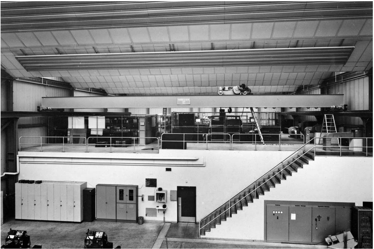
15 Zweiträgerkran, der von einer grossen Bühne aus unter Verwendung von Leitern mit Einhakvorrichtung und Bockleitern gewartet werden kann.
