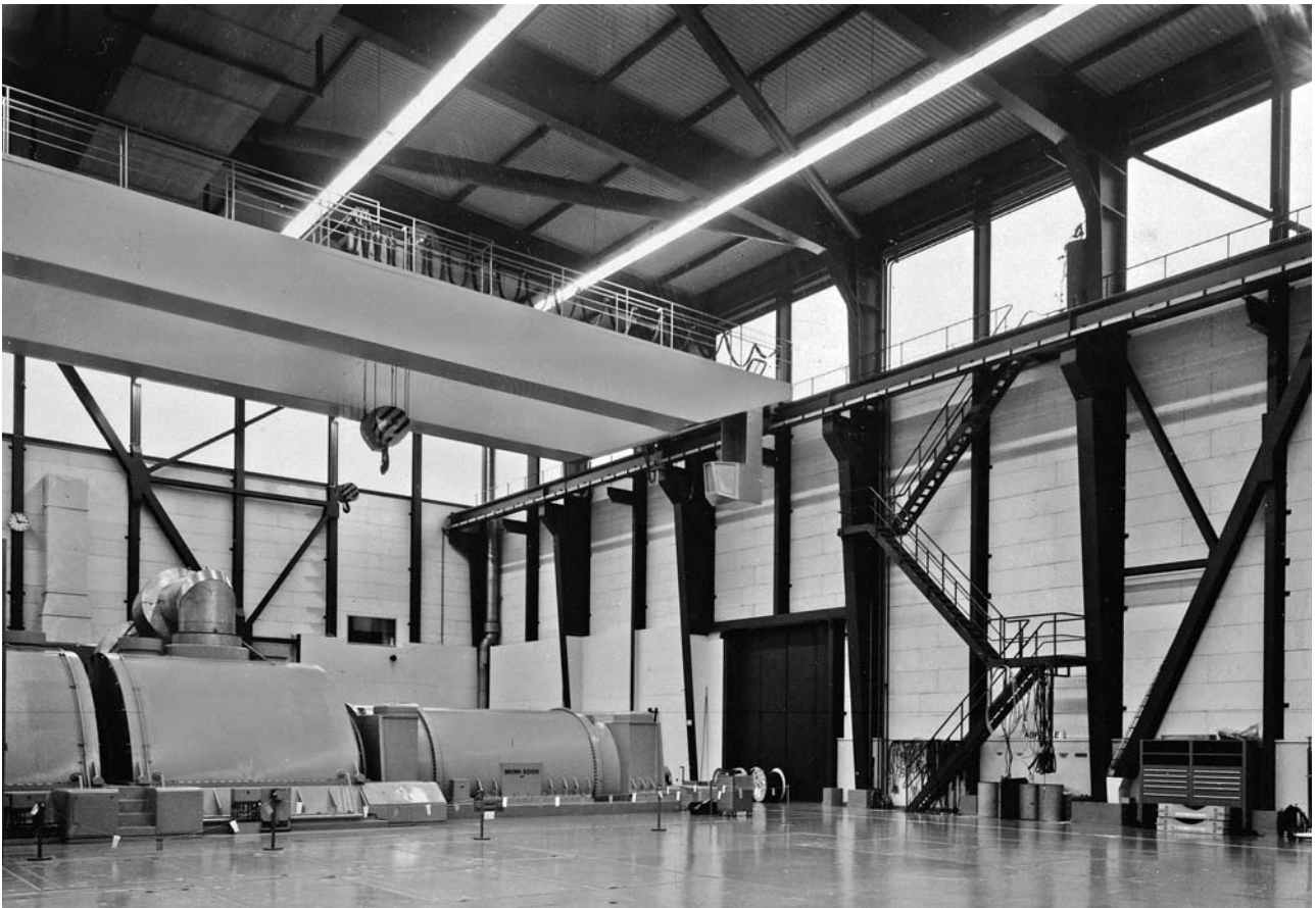
11 Treppenaufstieg zu Steuerstand und Wartungspodesten auf Zweiträgerkran.
