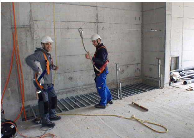
3 Installation d'une couverture avec des EPI antichute.
