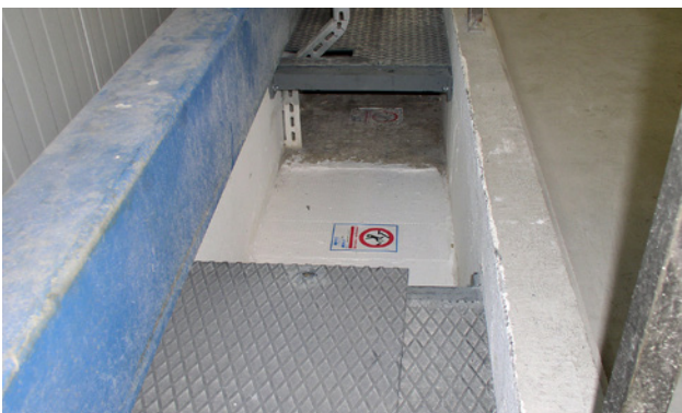
4 Élément coupe-feu avec tôle striée résistante à la rupture.
