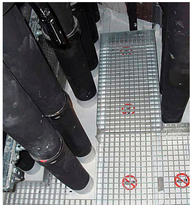
2 Éléments coupe-feu accessibles et résistants à la rupture.
