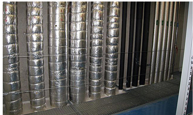
1 Élément coupe-feu horizontal protégé par une grille et résistant à la rupture.
