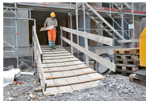
7 Sicherer Baustellenzugang mit Seitenschutz und Querstreben. Baustellenzugänge müssen mindestens 1 m breit sein.
