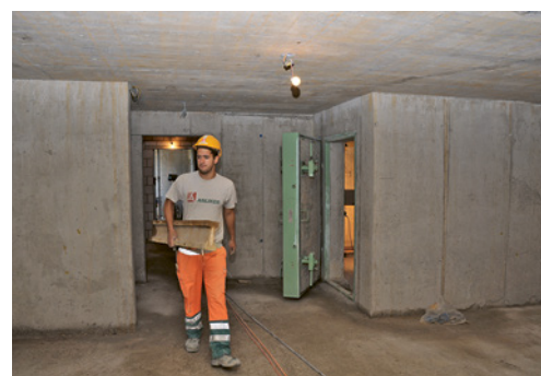
8 In Rohbauten muss eine Beleuchtung vorhanden sein.
