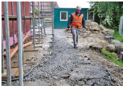
4 Dank des Magerbetons ist dieser temporäre Weg bei allen Wetterbedingungen sicher begehbar.
