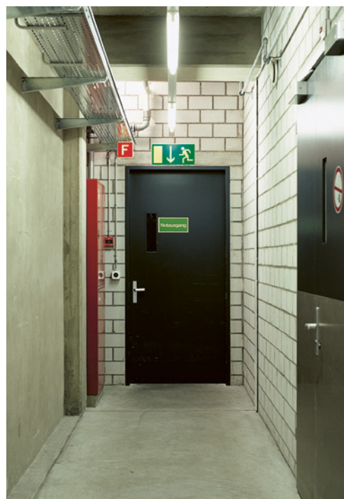
3 Voie d'évacuation avec porte s'ouvrant dans le sens de fuite.
