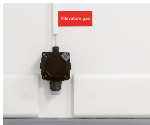
7 Impianto di rilevazione del gas
