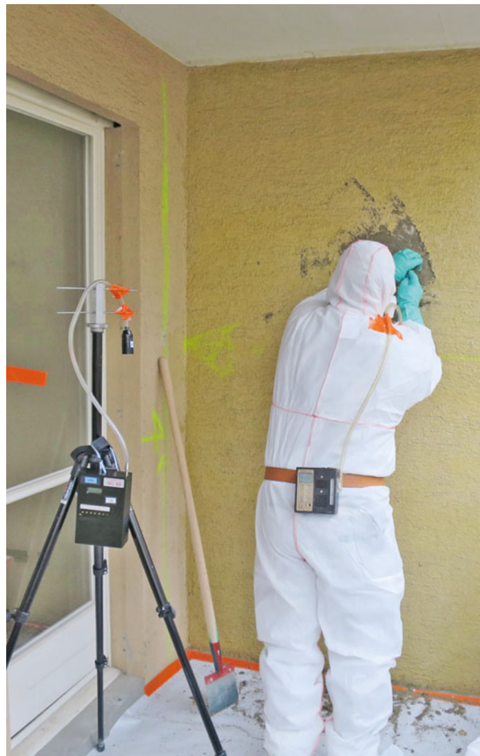
Esposizione all'amianto (concentrazione aerea) nei lavori di bonifica in funzione del tenore di amianto stimato nel materiale lavorato.
