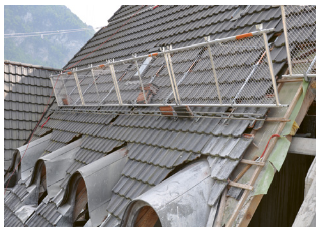
1 Paroi de retenue sur le toit correctement installée
