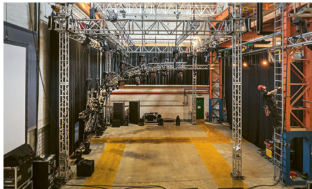
2 Impalcatura sospesa in un capannone
