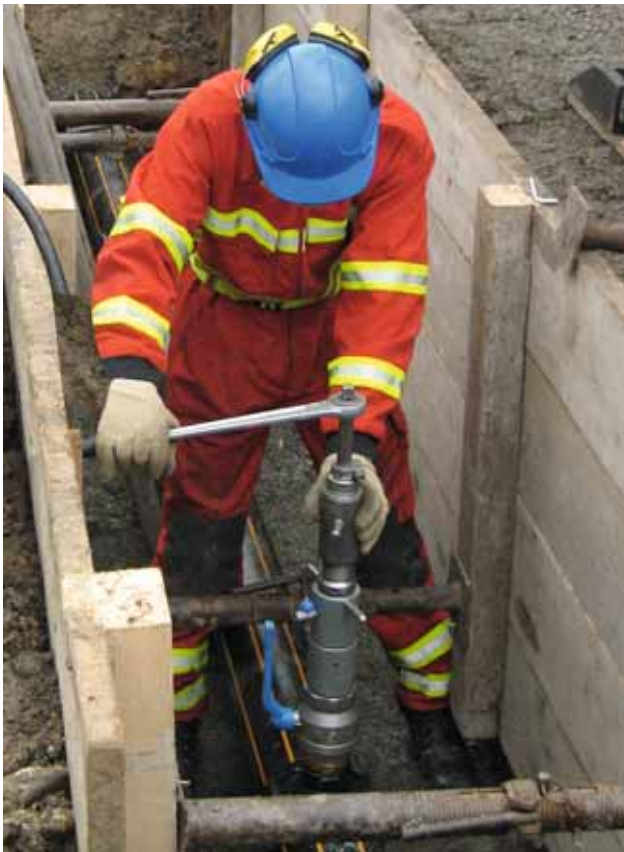
Fig. 1: perçage avec appareil à sas.
