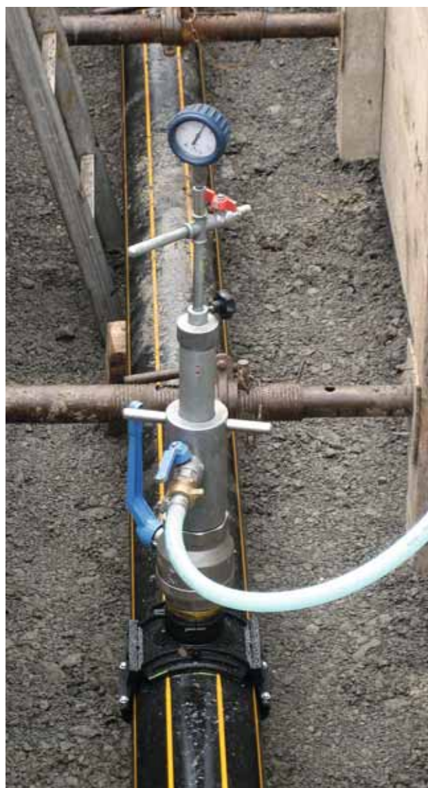
Fig. 23: contrôle de la pression dans le ballon d'obturation.
