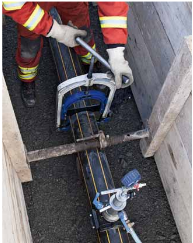
Fig. 25: séparation au moyen d'un coupe-tube.
