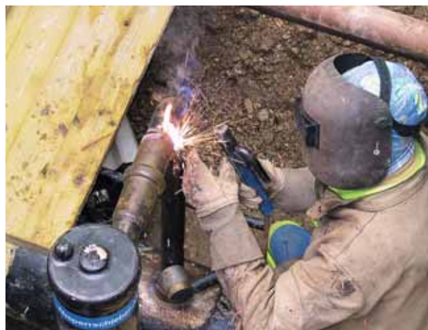
Fig. 5: soudage en gaz.
