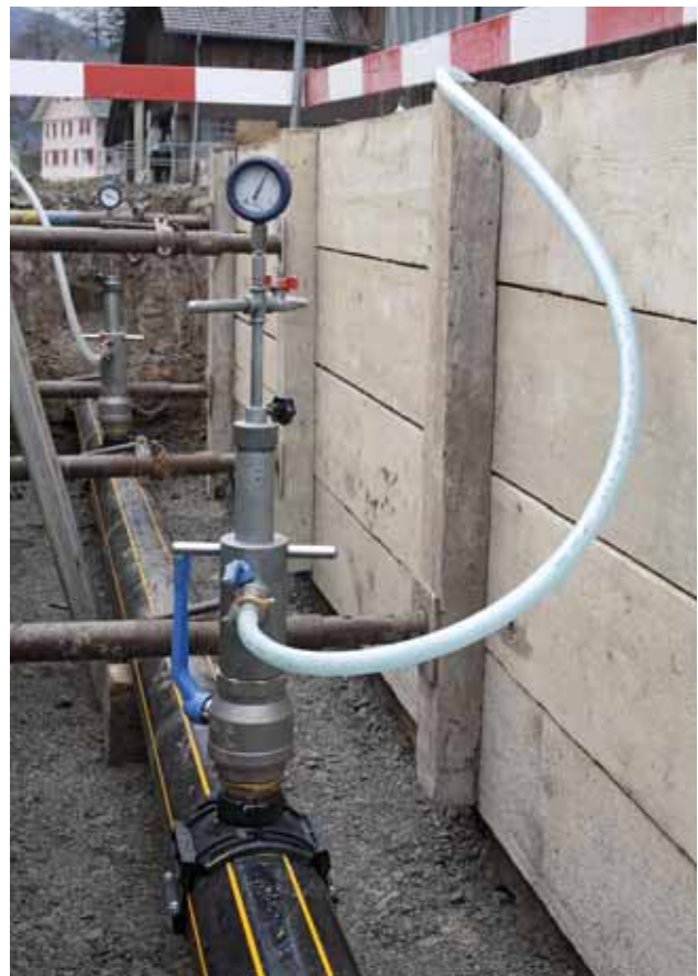
Fig. 2: ballonnage avec appareil à sas.
