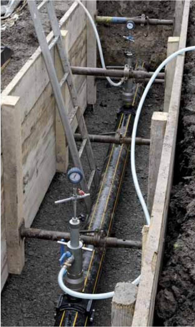
Fig. 12: deux appareils d'introduction de ballons obturateurs simples avec dispositif de purge (à l'air ou à l'azote) de la zone de travail.
