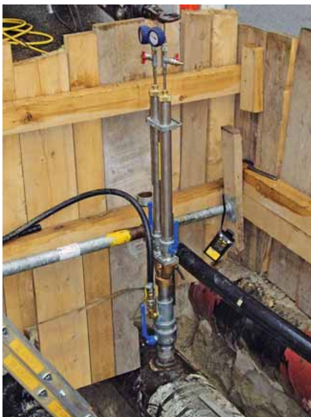
Fig. 26: mesure de présence de gaz dans la zone de travail.
