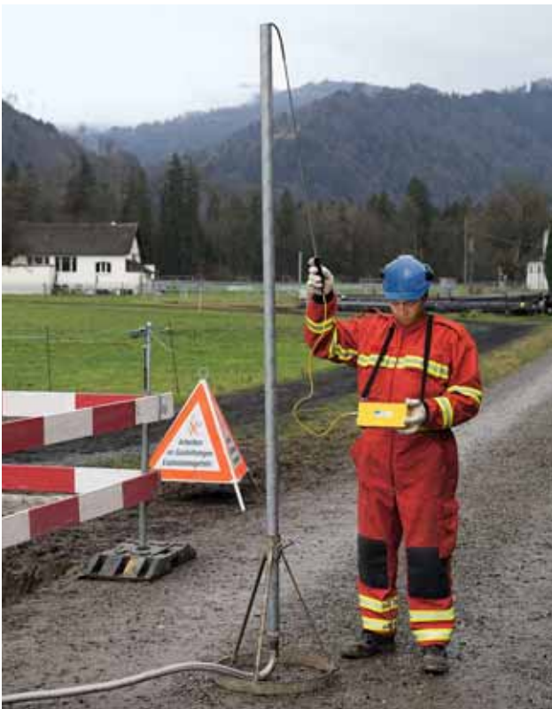
Fig. 24: évacuation du gaz naturel au travers d'un évent.
