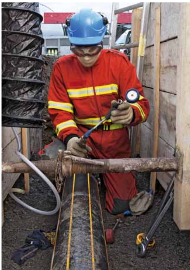
Fig. 3: ballonnage manuel.
