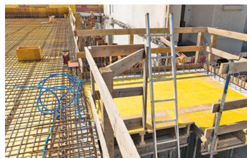
8 Die Leiter ragt mindestens 1 m über die Ausstiegskante, ein sicherer Überstieg mit Geländern ist sichergestellt.
