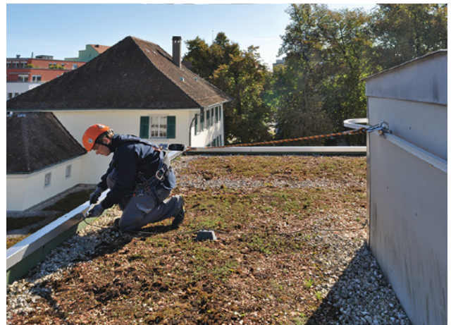
27 Rückhaltesysteme sind persönliche Schutzausrüstungen, die verhindern, dass die Person über die Dachkante stürzt. Rückhaltesysteme müssen immer den Auffangsystemen vorgezogen werden.
