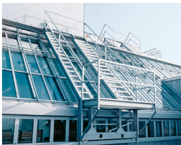
10 Fahrbare Brücke zum Reinigen der Aussenseite von schrägen Glasdächern. Dank des offenen Mittelbereichs und der seitlich angeordneten Treppen können von der Brücke aus auch defekte Glasscheiben ersetzt werden.
