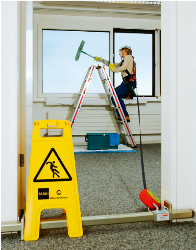
26 Fensterreinigung. Die Person ist mit einem Höhensicherungsgerät gesichert. Das Gerät ist z. B. an einer Traverse befestigt, die sicher am Türrahmen angeschlagen ist.
