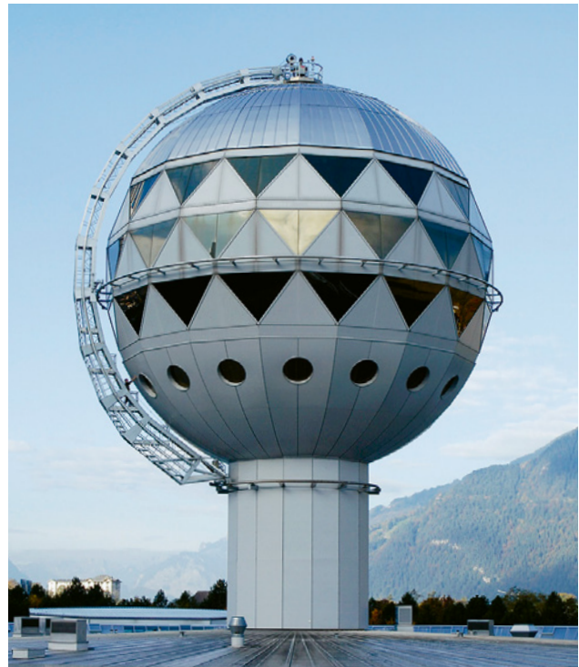
11 Fassadenbefahreinrichtung mit fixen Podesten für die Reinigung und Instandhaltung an einem speziellem Gebäude. Personen und Material sind gegen Absturz gesichert.
