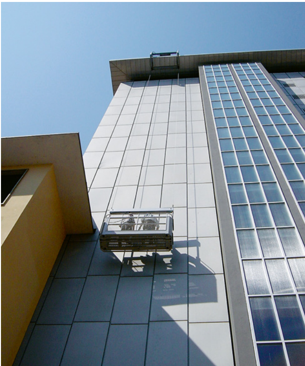
4 Fassadenaufzug mit Auslegern, die unter dem Dachvorsprung geführt werden. Dank Auslegern, die den örtlichen Verhältnissen angepasst sind, lassen sich auch schwer zugängliche Fassadenpartien erreichen.
