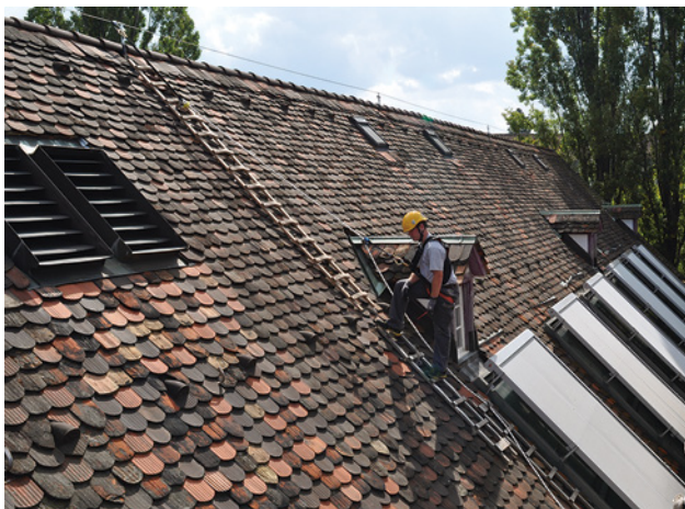
28 Arbeitsplatz-Positionierungssysteme sind persönliche Schutzausrüstungen. Sie ermöglichen es der Person, durch Hineinlehnen ins System eine Arbeitsposition einzunehmen, bei der ein Absturz ins Verbindungsmittel verhindert wird.
