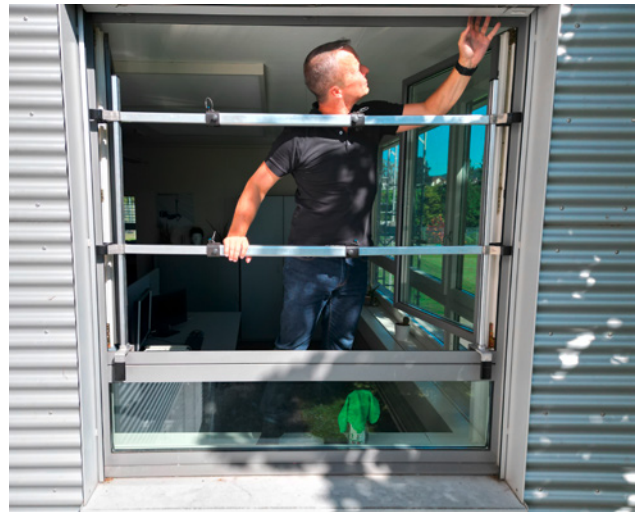
20 Flexibel einsetzbare Fenstersicherungen werden vom Gebäudeinnern her in die Fensteröffnung eingesetzt und gewährleisten sichere Arbeitsstandorte.
