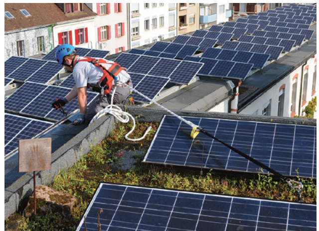
29 Auffangsysteme sind persönliche Schutzausrüstungen, welche die abstürzende Person auffangen und die einwirkenden Kräfte (Fangstoss) auf die Person begrenzen.
