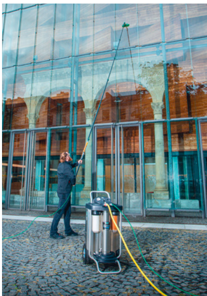
23 Das Reinigen mit der Teleskopstange kann vom Boden oder von einem sicheren Stand ausgeführt werden.
