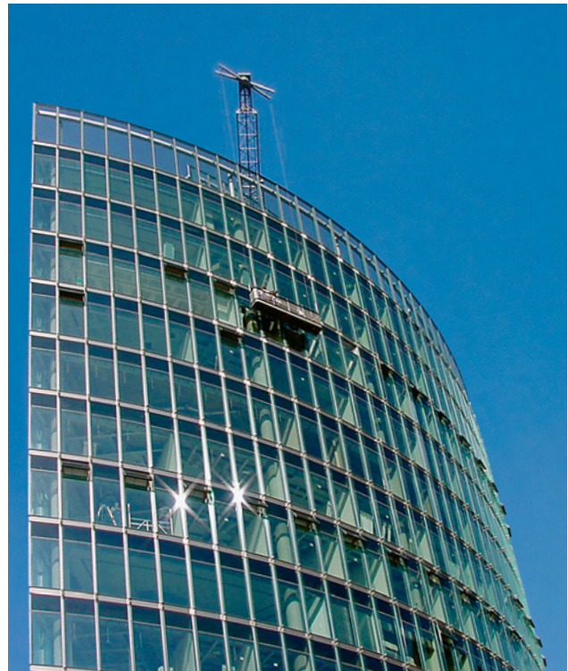
5 Mit dem hochziehbaren und seitlich verschiebbaren Arbeitskorb oder Arbeitsbühne lässt sich jede Stelle der Fassade schnell und sicher erreichen.
