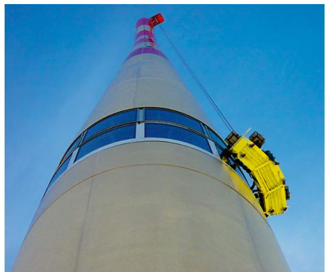
12 Sendeturm mit speziell der Rundung angepasster Befahranlage. Für den Betrieb der Anlage werden die Ausleger an der Turmspitze nach aussen geklappt.
