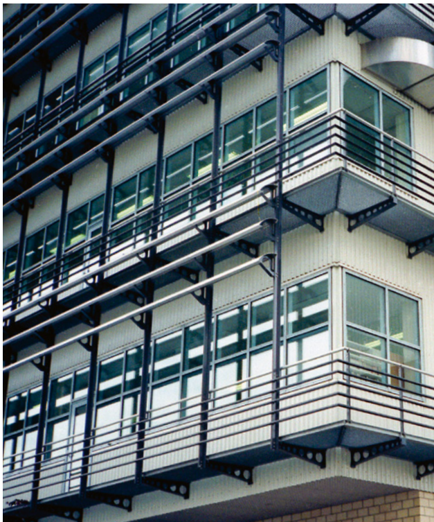
1 Balkone mit Geländern. Sie ermöglichen es, dass die Fenster aussen gefahrlos gereinigt werden können.
