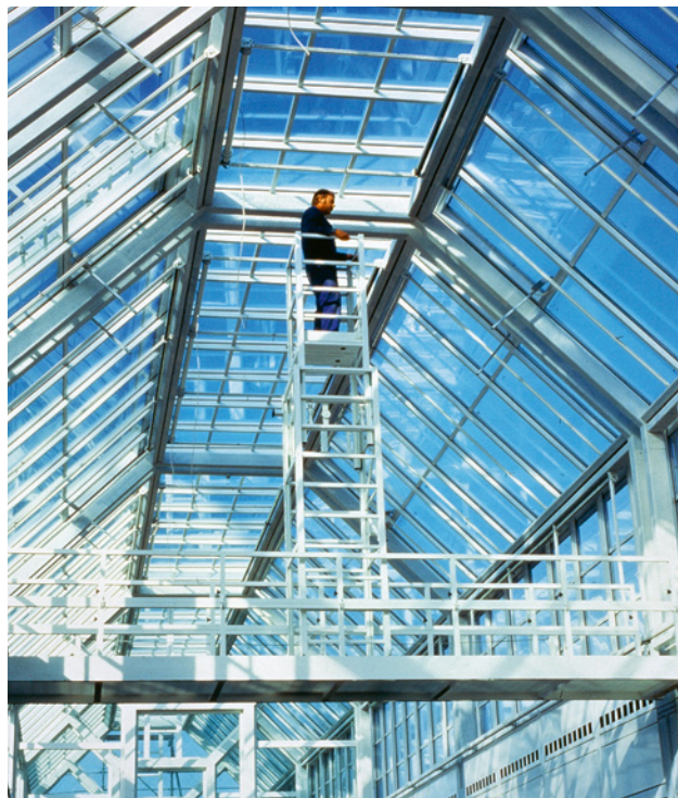
9 Fahrbare Brücke mit verschiebbarem und höhenverstellbarem Leiterturm in einer Glashalle. Mit diesem Gerät kann die ganze Glasfläche sicher und bequem gereinigt werden.
