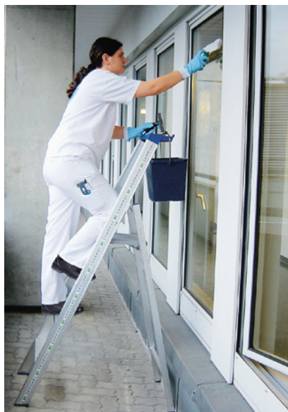
24 Da die Arbeit nicht vom Boden aus erledigt werden kann, wird eine Stufenleiter mit Plattform eingesetzt (bis max. 2 m Standhöhe).
