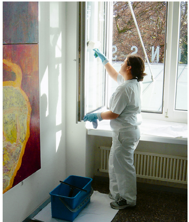
2 Fenster, das sich nach innen öffnen lässt. Das Reinigungspersonal kann auch die Aussenseiten sicher reinigen.
