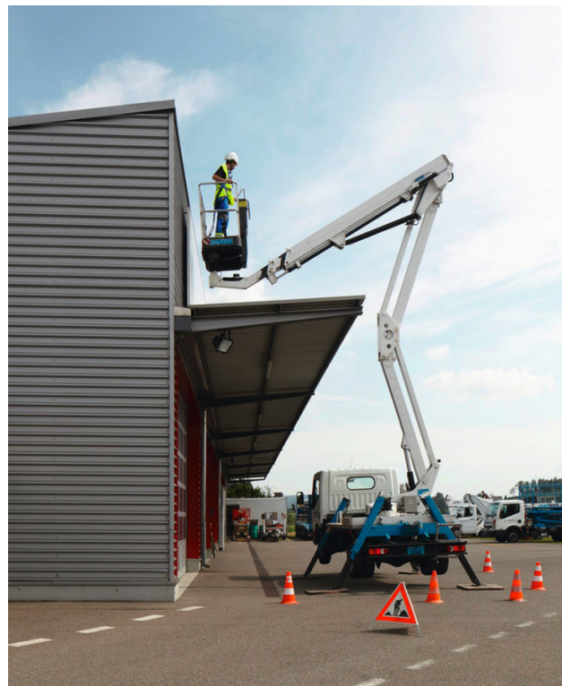
18 Reinigungs- und Instandhaltungsarbeiten mit Hilfe einer Hubarbeitsbühne.
