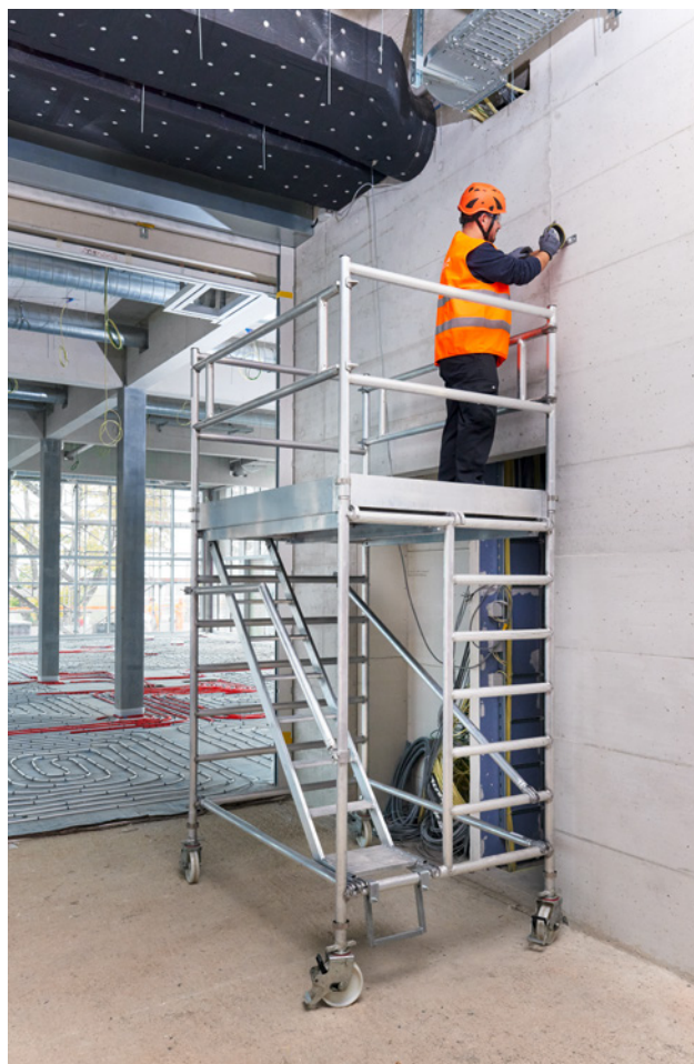
22 Arbeiten von einem Rollgerüst aus.
