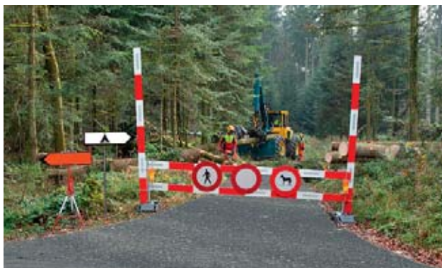
2 Beispiel der Absperrung einer Waldstrasse mit rot-weiss gestreiften Latten und den notwendigen Signalen für alle Verkehrsteilnehmer
