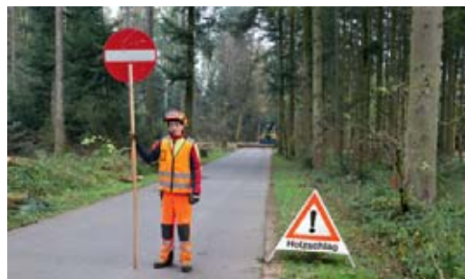
1 Signalisierte Arbeitsstelle im Wald mit Verkehrsregelung
