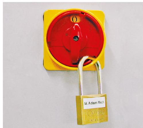
5 Sicherheitsschalter, der sich mit einem persönlichen Vorhängeschloss sichern lässt. Bei jedem Sicherheitsschalter muss angeschrieben sein, welchen Bereich der Anlage er abschaltet.
