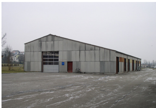
1 Mit Wellplatten aus Faserzement verkleidete Industriehalle
