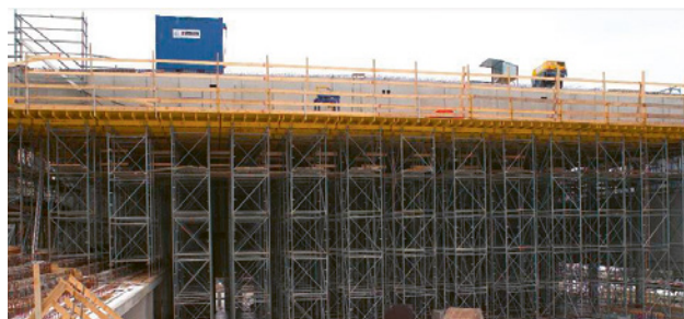
3 Sistema di cassetta moderno per strutture con soffitti alti
