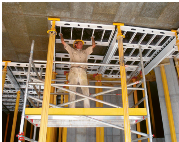
1 Système moderne: coffrage et décoffrage par le bas.
