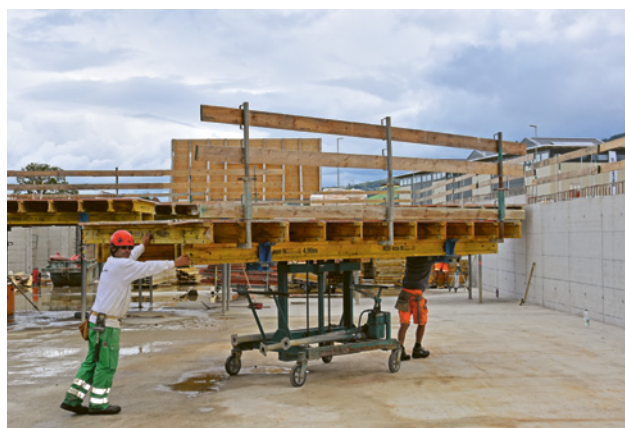
5 Élément de coffrage de dalle avec protection collective prémontée (garde-corps en trois parties).
