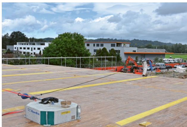
3 Coffrage avec système d'assurage testé et certifié conforme.
