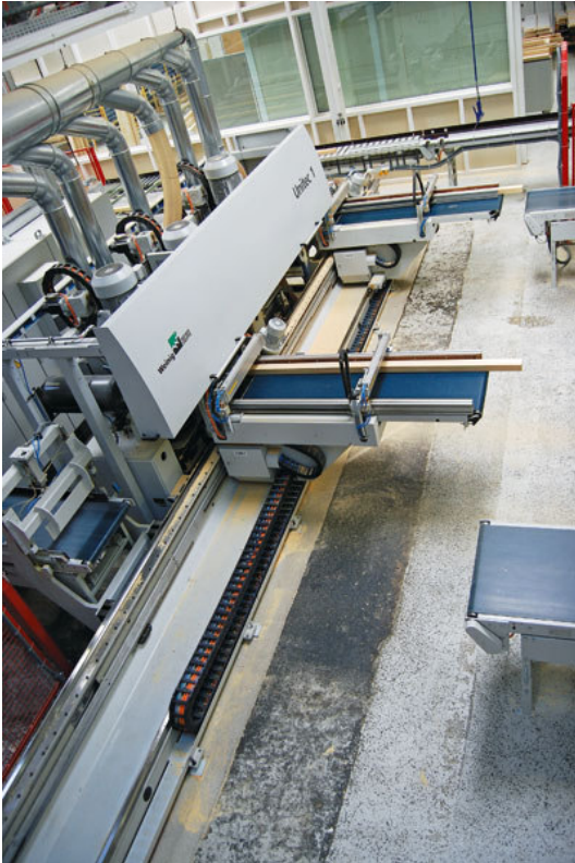
Hier mit manipulierten Schutzeinrichtungen zu arbeiten wäre gefährlich: Die Wagen mit dem Holz fahren schnell.
