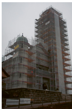
2 Regelkonformes Fassadengerüst
