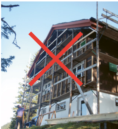
5 bis 7 Mangelhafte, unzulässige Fassadengerüste
