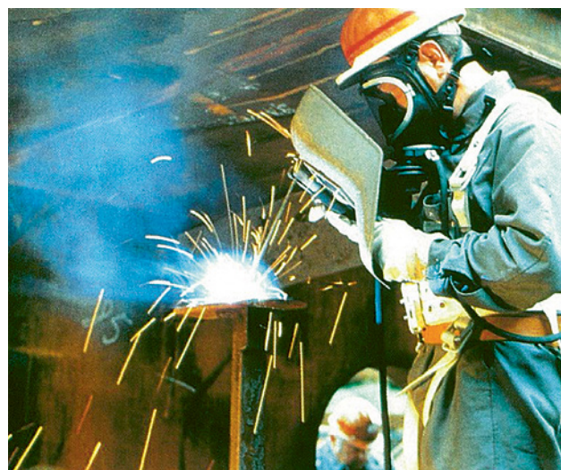
Fig. 42 Soudeur portant un appareil respiratoire alimenté par tuyau, indépendant de l'air ambiant, pour application dans les locaux exigus, par ex. dans une cave sans fenêtre
