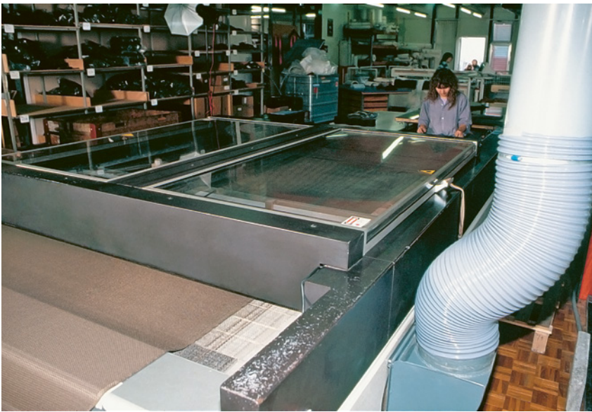
Fig. 32 Capotage et aspiration d'une installation de découpe au laser
