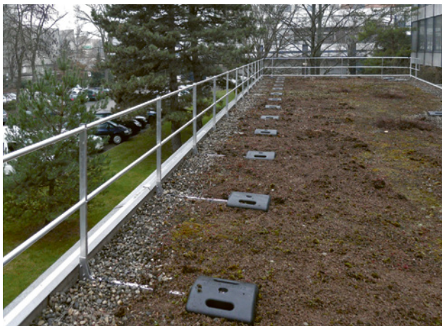
1 Une protection collective offre une sécurité optimale au bord du toit.
