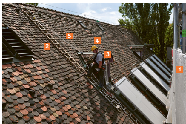
12 Système de maintien au poste de travail sur un toit en pente
