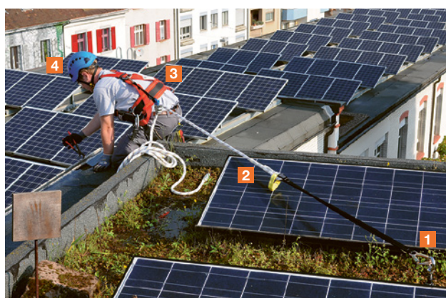
13 Système d'arrêt des chutes
