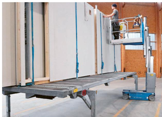
1 Sicherung der Holzelemente mit Zurrmittel.
