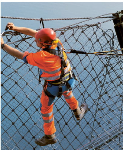
1 Oltre alle conoscenze tecniche di montaggio e PDI anticaduta, questi lavori richiedono calma, forza e resistenza.
