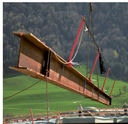
3 Limitare il più possibile i lavori con i DPI anticaduta effettuando il premontaggio a terra.
