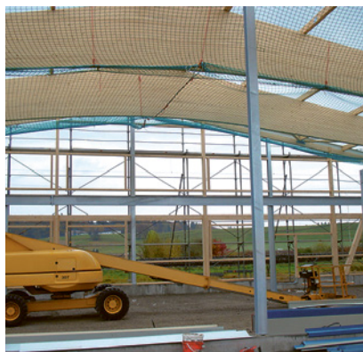
2 Prima di usare i DPI anticaduta verificare la possibilità di impiegare le piattaforme di lavoro elevabili.
