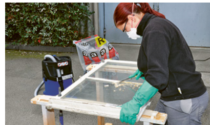
2 Schutzmassnahmen beim Entfernen von asbesthaltigem Fensterkitt
