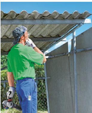
Regel 9 Asbeststaub vermeiden.
