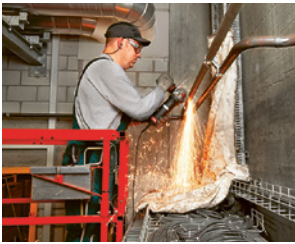
1 Schutz der elektrischen Leitungen
