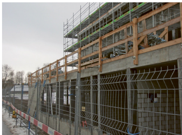
1 Korrekter dreiteiliger Seitenschutz gemäss SN EN 13374
