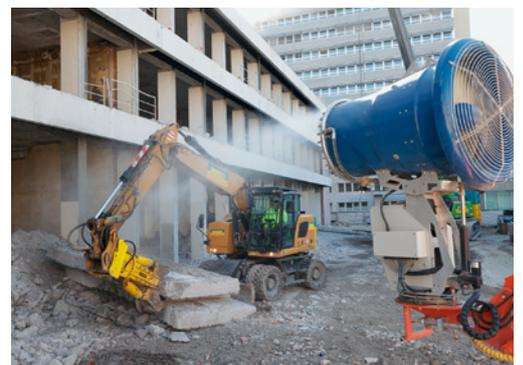
6 Die Staubentwicklung mit geeigneten Massnahmen eindämmen, z. B. mit Bedüsung am Abbaugerät, Benetzen mit Wasser.
