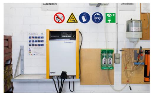
5 Station de recharge des batteries réglementaire avec interdiction de fumer. Des lunettes de protection et une douche oculaire sont à disposition.
