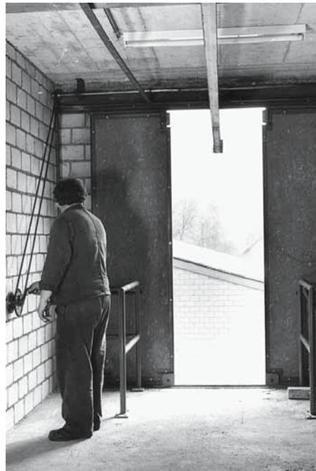
Figure 5 e 6: apertura nella parete per il trasporto di merci per mezzo di un paranco su monorotaia che esce all'esterno. La porta scorrevole può essere aperta e chiusa a distanza senza correre alcun pericolo; è possibile anche azionare il paranco e comunicare con l'addetto all'aggancio del carico da un posto sicuro.
