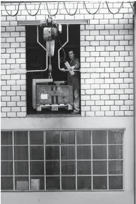
Figura 4: apertura destinata al trasporto di merci con un apparecchio di sollevamento. Il parapetto non è continuo in modo da consentire il passaggio dell'apparecchio.
