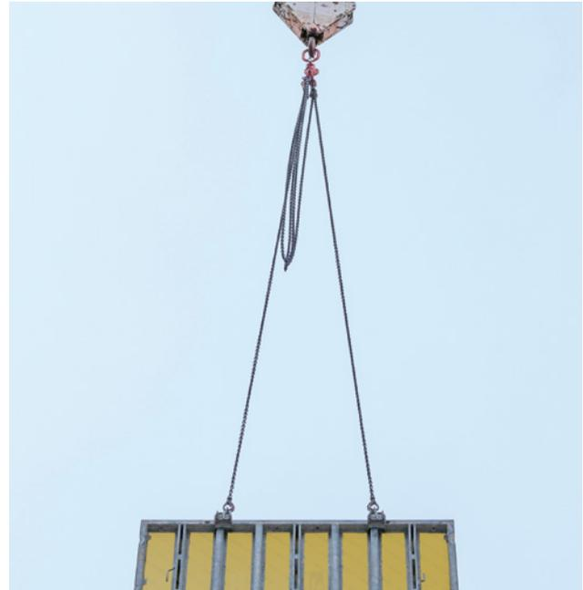
6 Krantransport eines Wandschalungselements mit zwei Umsetzbügeln (Versetzhaken)
