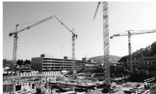
1 Si les grues peuvent se toucher ou entrer en contact avec le câble de levage par le biais de leur flèche ou de leur contreflèche (chevauchement dans les zones de travail), il convient d'appliquer les mesures de sécurité décrites dans la publication Suva 66061.f.
