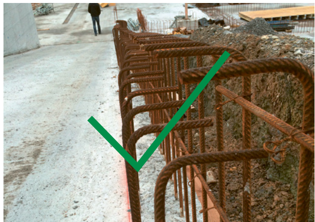
2 Fers d'armature en attente recourbés
