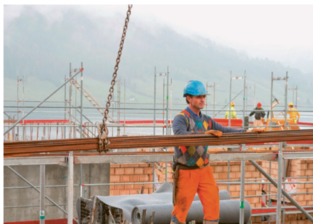
4 Transport par grue d'un paquet de fers d'armature
