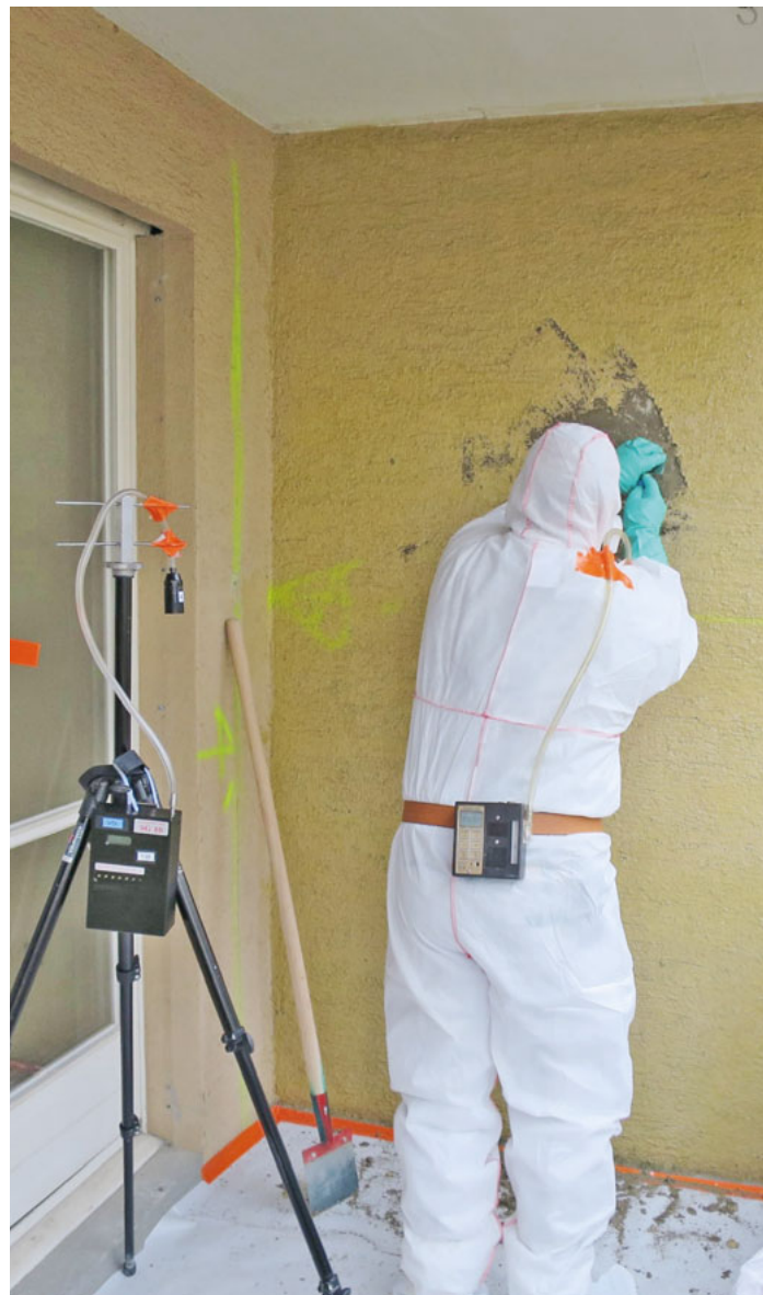
Stationäre und personenbezogene Luftprobenahme bei der Entfernung von Fassadenputz.
