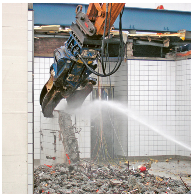
Carreaux en céramique avec colle amiantée
