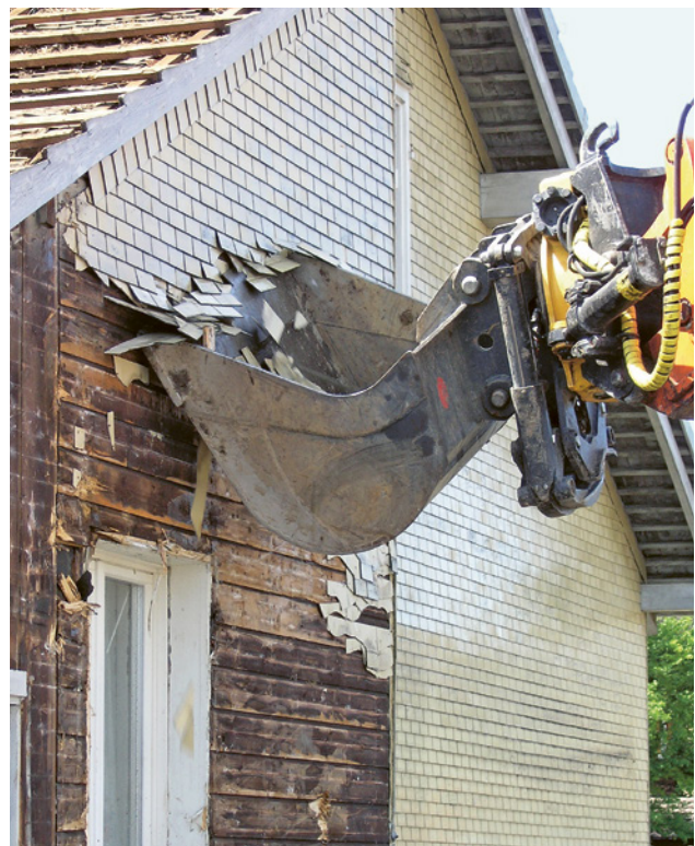
Bardeaux en fibrociment amianté
