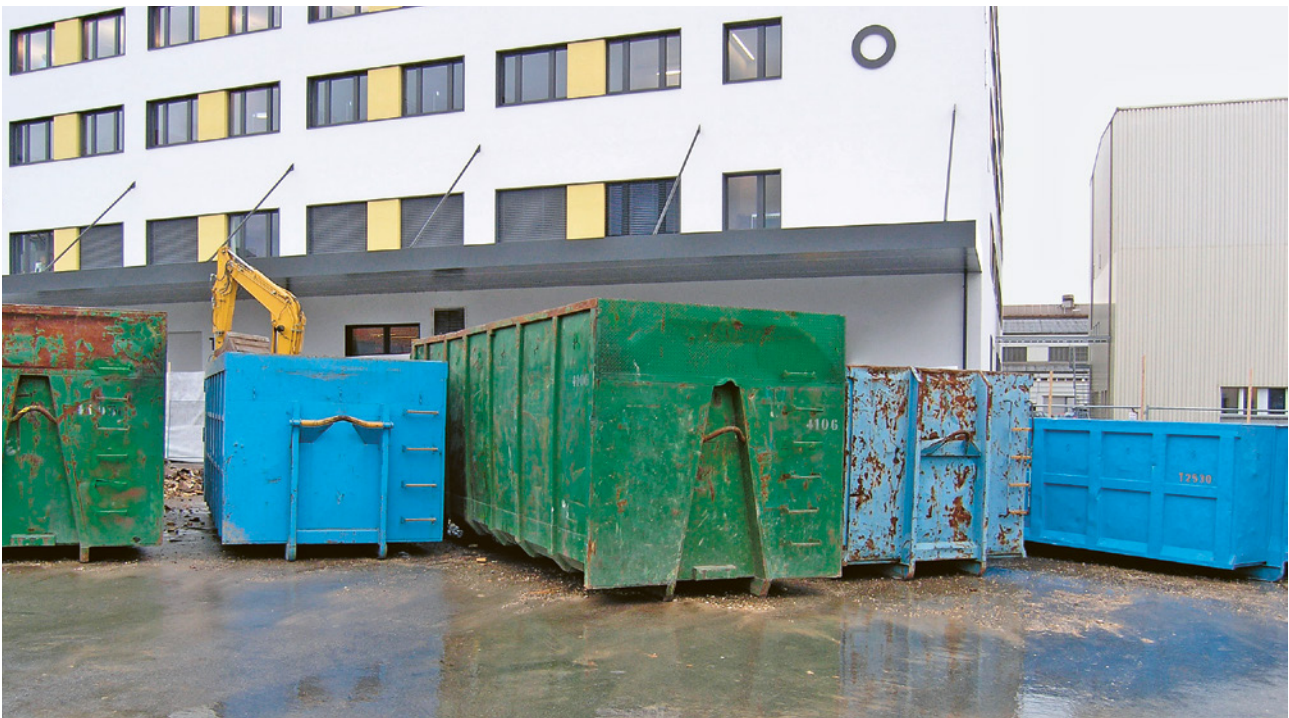
Bennes pour matériaux amiantés
