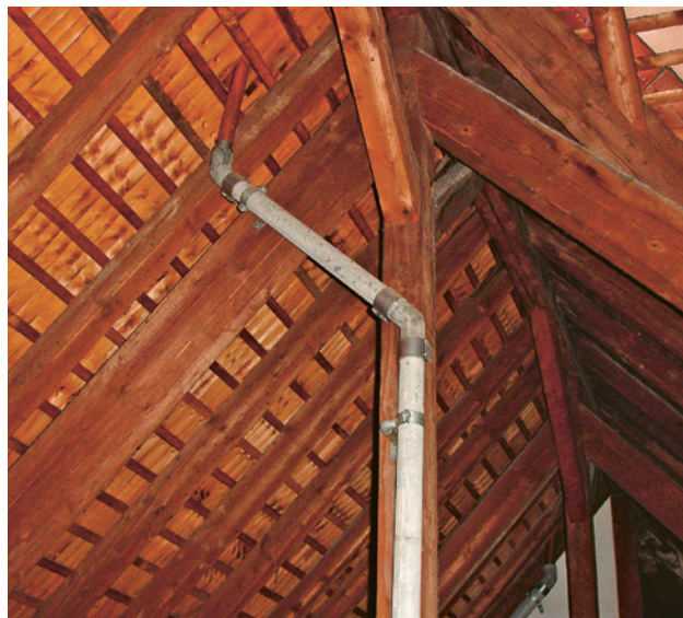
Conduites en fibrociment amianté
