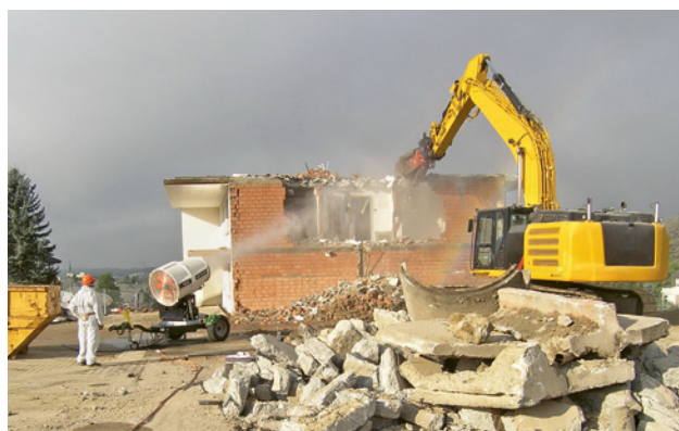
Déconstruction avec une pelle mécanique hydraulique
