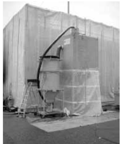
Figure 2: installation d'aspiration et de dépoussiérage, coffrage avec une légère dépression.
