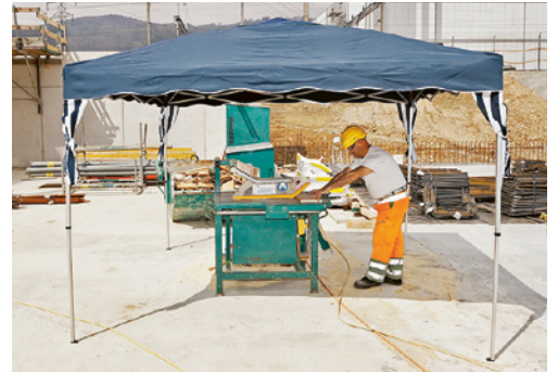
3 Se possibile, ombreggiare i luoghi di lavoro. Si tratta della protezione più efficace.
