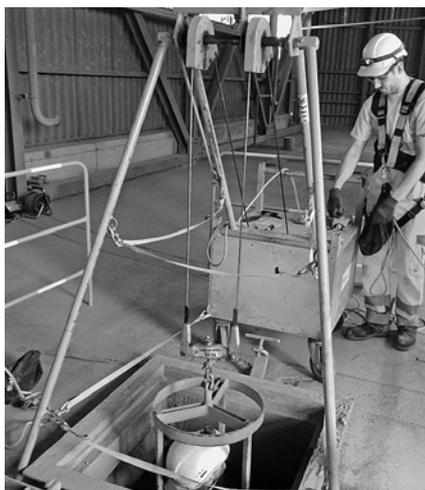
11 Descente dans le silo au moyen d'un treuil de silo et d'une nacelle. Ces équipements doivent être conformes aux normes européennes.
