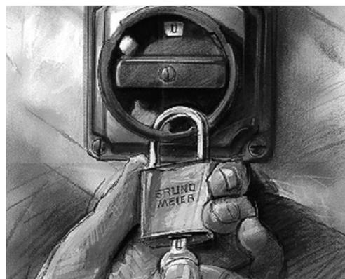
8 Interrupteur de sécurité en position 0 et verrouillé avec un cadenas individuel
