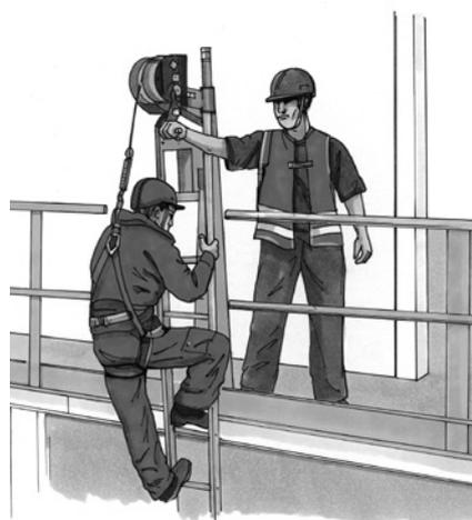
12 Descente dans le silo au moyen d'une échelle associée à un antichute à rappel automatique équipé d'un dispositif de sauvetage
