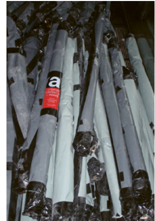
5 Eingepackte Rohrleitungen, bereit für den Transport zum Asbestsanierungsunternehmen
