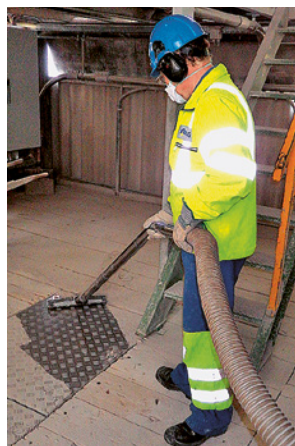
2 Rimozione degli accumuli di polvere con aspiratore
