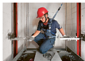
1 Toit de la cabine
