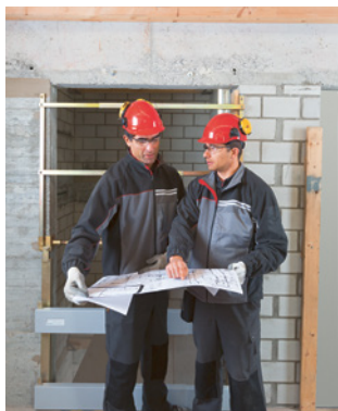
Règle 1 Planifier les travaux.
