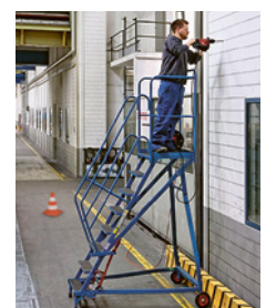
3 Arbeitspodest für Arbeiten in der Höhe
