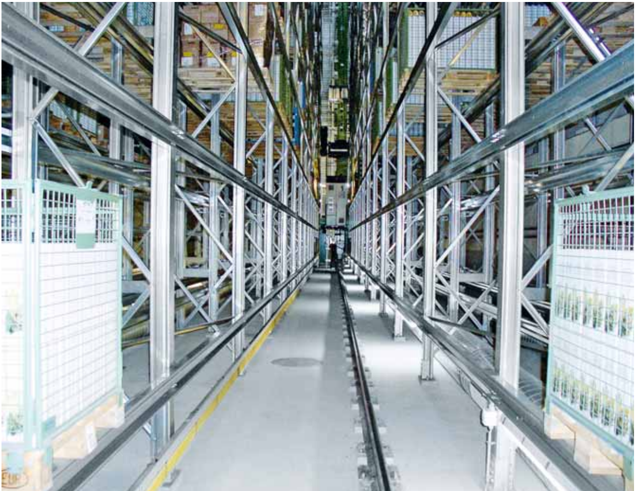
1 Dans les entrepôts appauvris en oxygène, les travailleurs doivent être protégés contre les atteintes à la santé.
