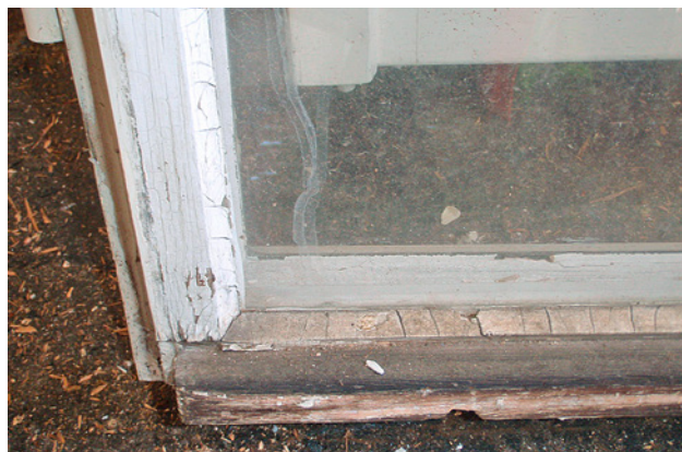
1 Stucco a base di olio di lino contenente amianto in una finestra in legno
