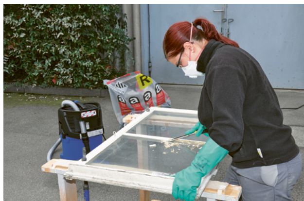
2 Rimozione dello stucco per finestre contenente amianto con lo scalpello o la spatola
