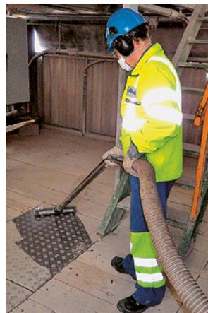
2 Entfernen von Staubablagerungen mit dem Staubsauger
