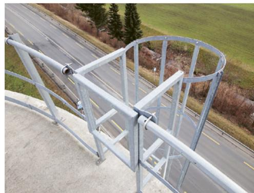
5 Sichere Gestaltung des Leiterausstiegs mit selbstschliessender Durchgangssperre.
