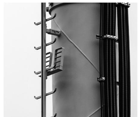
11 Ausklappbare Tritte an einer Steigleiter mit Mittelholm
