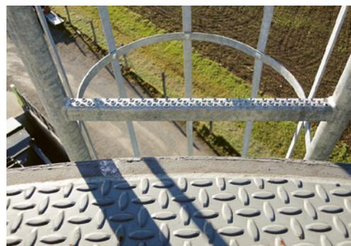
4 Rutschhemmend gestaltete Sprossenoberfläche. Die oberste Sprosse liegt auf gleicher Ebene wie die Lauffläche des Podests.
